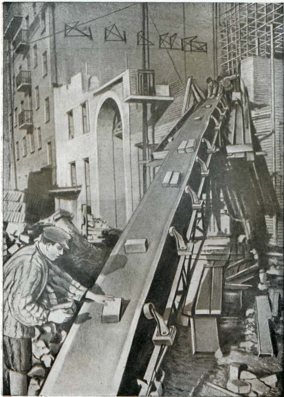
Подача кирпичей на стройку при помощи транспортера.
