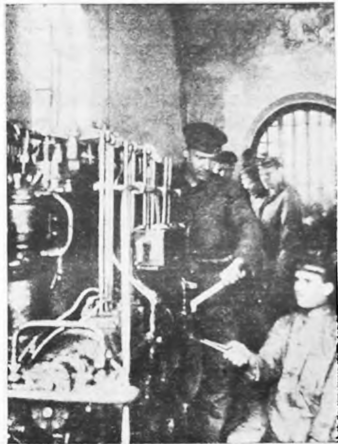
Машинисты за ремонтом машины.
